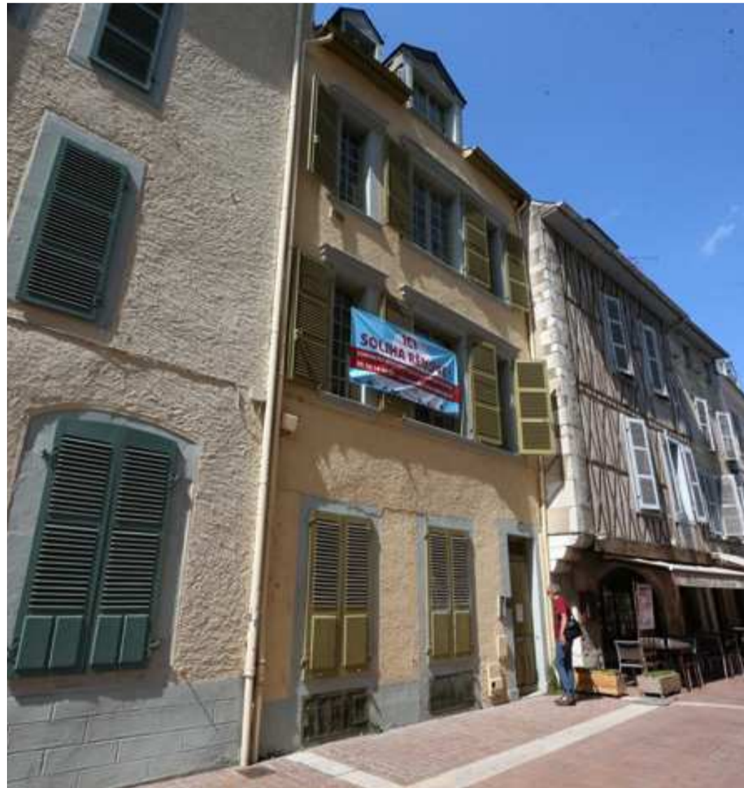
Un immeuble en rénovation par Soliha dans le quartier du château à Pau. © JEAN-PHILIPPE GIGNONNET
